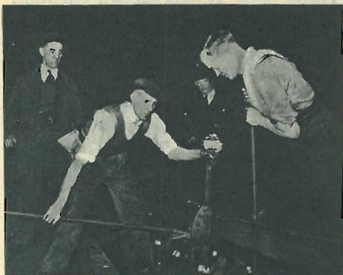
Sopra: La rapida sostituzione di una rotaia.
